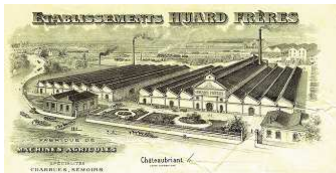
Un site industriel qui a été détruit récemment
